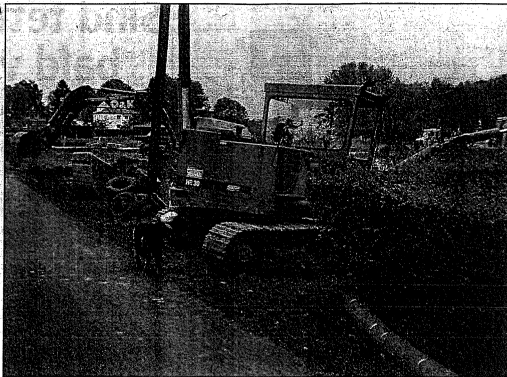
Für die Friedhofserweiterung von Ehringhausen sind umfangreiche Erdarbeiten erforderlich geworden. ■ Foto: Gehre
